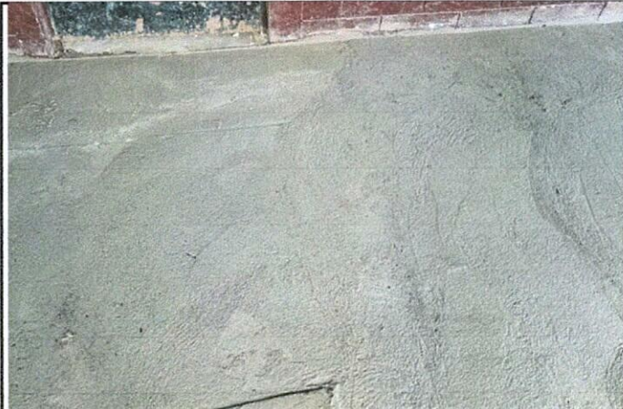
Foto 4: Remodelación del piso de los corredores
