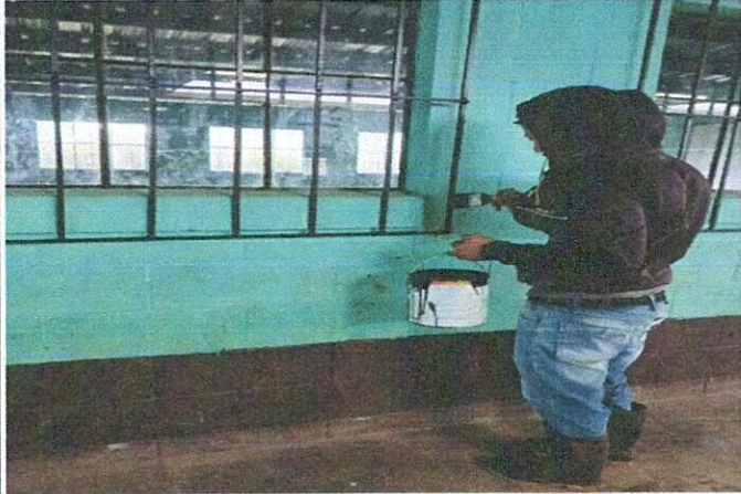
Foto 1: Pintura de veintiséis balcones
