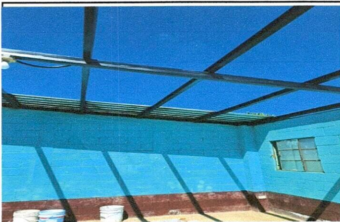
Foto 3: Cambio del techo de un aula
